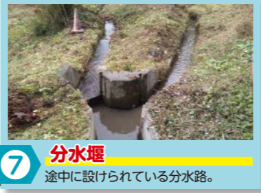
7 分水堰 途中に設けられている分水路。
