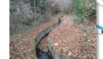
地形に逆らい勾配をとりながら蛇行を繰り返す水路。昔は手掘り、かつ土側溝だったというからすごい！
