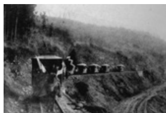
「大正3年開通の日」 茂庭と赤石の間に位置する馬尾坂の川沿いのカーブ付近
